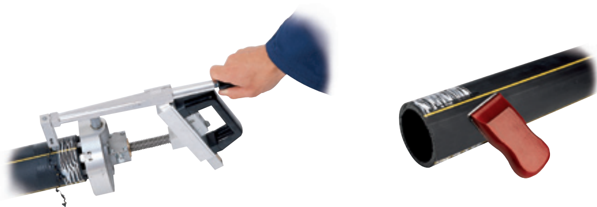
Cleaning the pipe with mechanical scraper code 3855 and hand scraper code 3856 Rohrreinigung mit mechanischem Abschaber Cod. 3855 und manuellem Abschaber Cod. 3856 Зачистка труб при помощи металлического скребка код 3855 и ручного скребка код 3856
